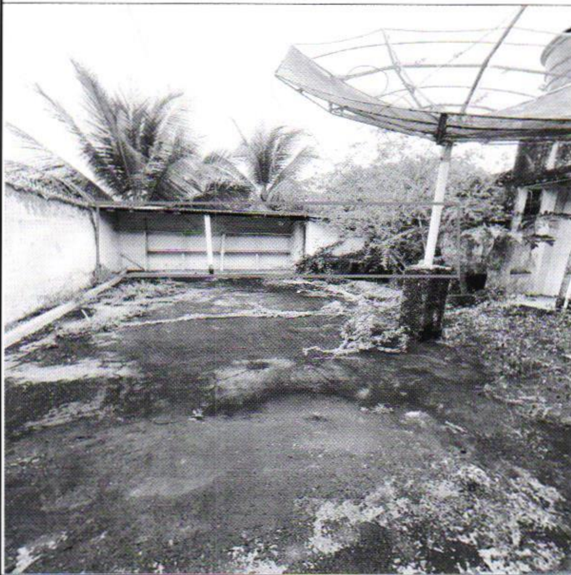
FOTO 17 – Área externa coberta
